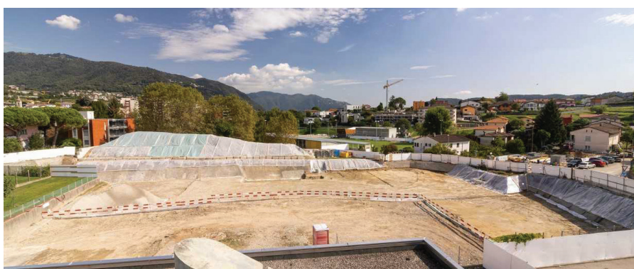
Evoluzione del cantiere del futuro Parco San Rocco di Coldrerio
